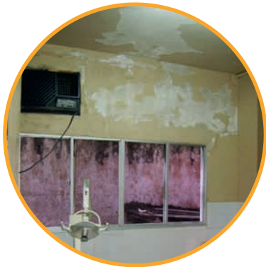
USF José Carneiro Leão antes da reforma
