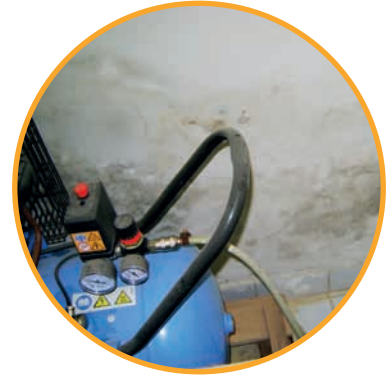
USF N.Sª do Carmo- interdição em camaragibe
